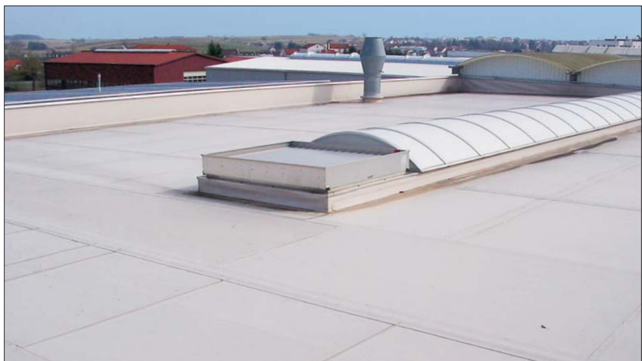
Bild 3: Übersichtsaufnahme Dachfläche des Objektes Tries in Ehingen (D)
