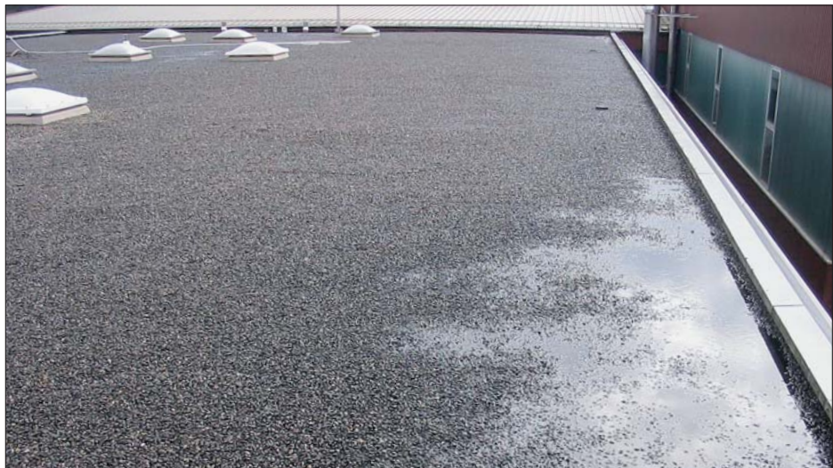
Bild 2: Übersichtsaufnahme Dachfläche Brunner, Flawil (CH)
