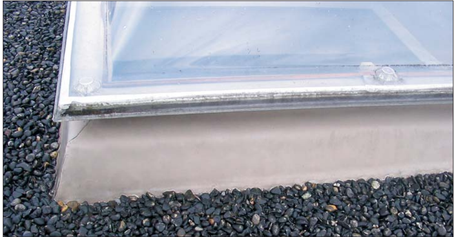
Bild 4: Anschluss an Lichtkuppel, Dachfläche Brunner, Flawil (CH)
