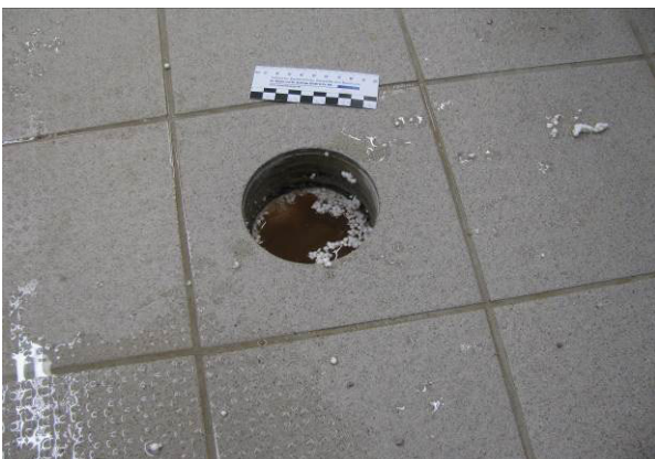
Bild 9: Zu Untersuchungszwecken eingebrachte Kernbohrung, mit im Bodenaufbau stehendem Wasser.
