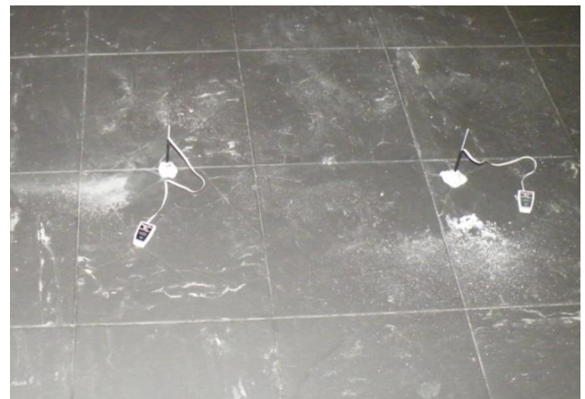
Bild 6: Hygrometrische Feuchtemessung im Baustoff. Hier: Überprüfung eines Bodenaufbaus nach einem Wasserschaden.
